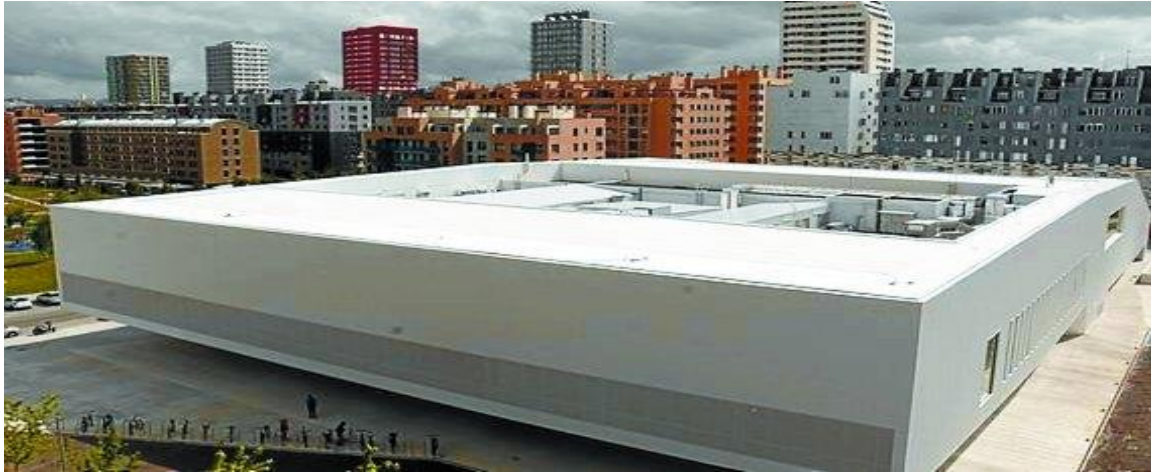
Cubierta del Centro Cívico de Salburua con capacidad de generar 640 MWh al año
