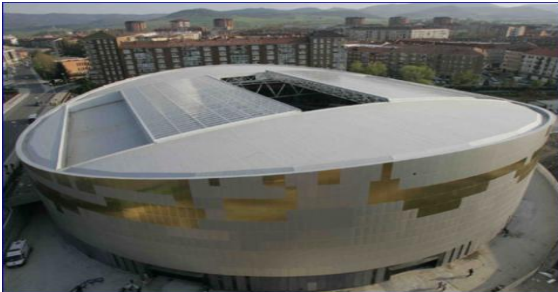
Cubierta Iradier Arena con capacidad de generar 485 MWh al año
