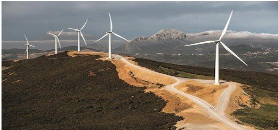
Desmontes en crestas de montaña para parque eólico.
